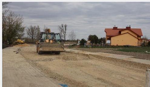
Przebudowa drogi gminnej (boczna ul. Gródeckiej) z kanałem deszczowym i oświetleniem.
