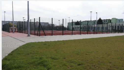
Budowa kompleksu boisk i obiektów lekkoatletycznych przy Zespole Szkół Miejskich Nr 3 w Hrubieszowie (obecnie przy Szkole Podstawowej Nr 3 w Hrubieszowie)
