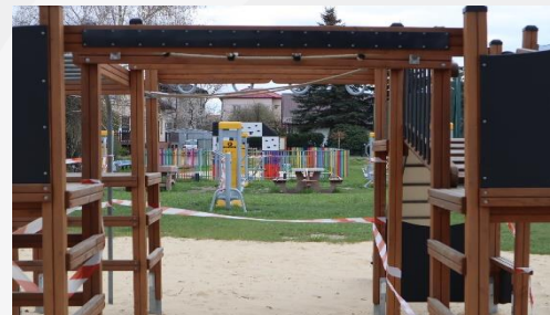
Budowa małej infrastruktury sportowo - rekreacyjnej na Osiedlu Jagiellońskim w ramach programu Otwarte Strefy Aktywności
