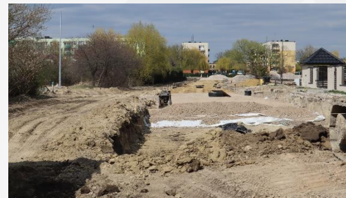
II etap budowy dróg gminnych na Osiedlu Basaja w Hrubieszowie - ul. Storczykowa, Konwaliowa i Tulipanowa
