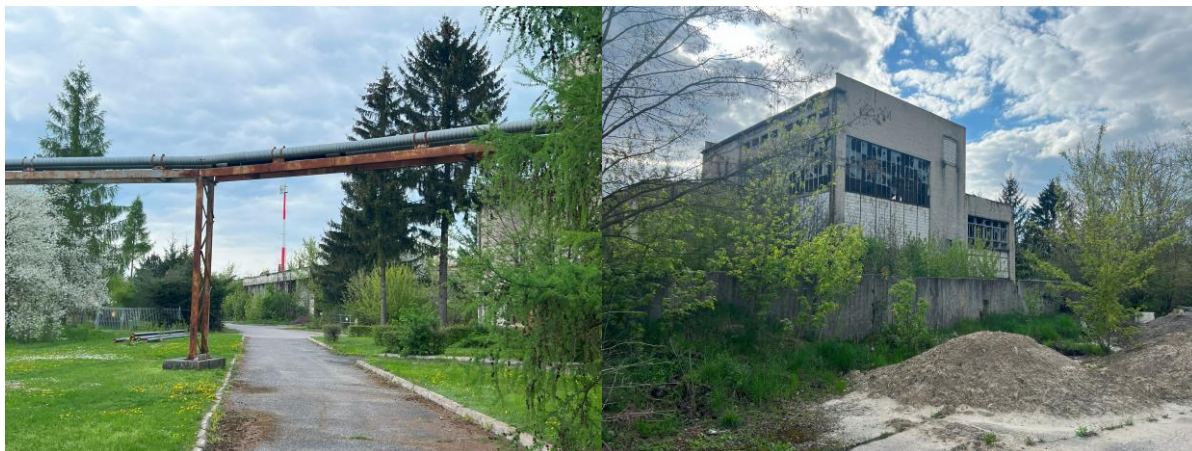
Zdjęcie 17. Budynki socjalne przy ul. Gródeckiej.
