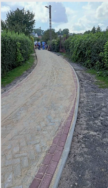
Remont odcinka traktu pieszego z ul. Ceglanej do ul. Grunwaldzkiej
