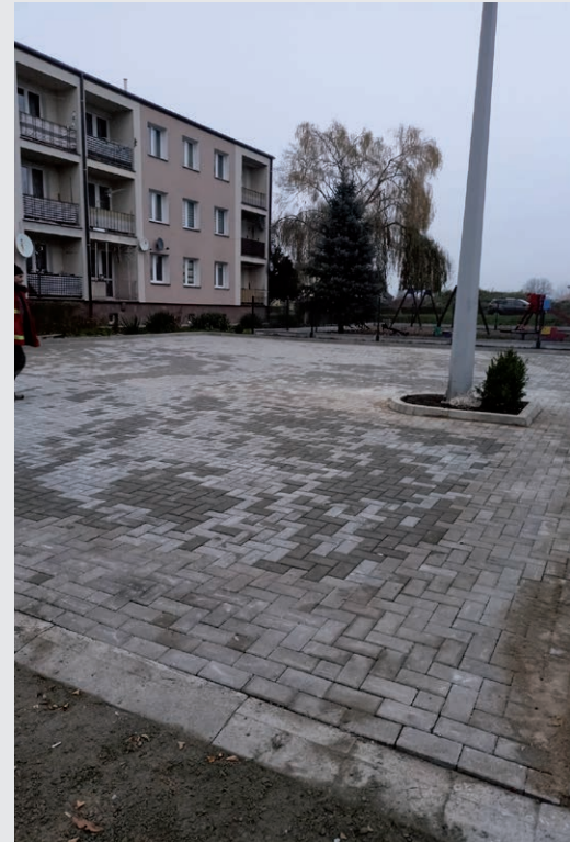
Miejsca parkingowe przy ul. Zamojskiej po remoncie
