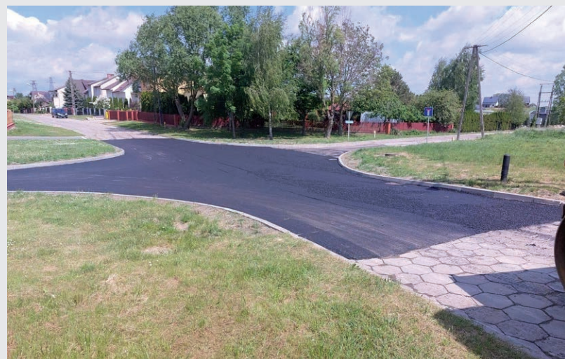
Nowa nawierzchnia na skrzyżowaniu ulic Reja i Kochanowskiego
