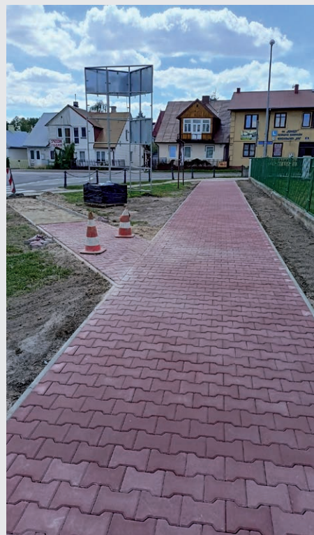
Przebudowa chodnika przy ulicy Żeromskiego
