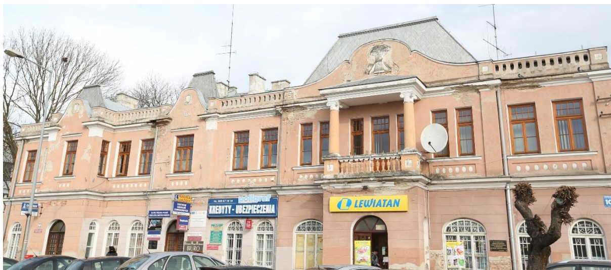
Zdjęcie 12. Widok elewacji frontowej budynku d. Syndykatu Rolniczego w Hrubieszowie
