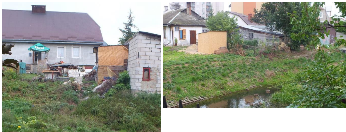
Zdjęcie 10. Widok substandardowej zabudowy w dolinie rz. Ulgi oraz rz. Huczwy w Hrubieszowie
