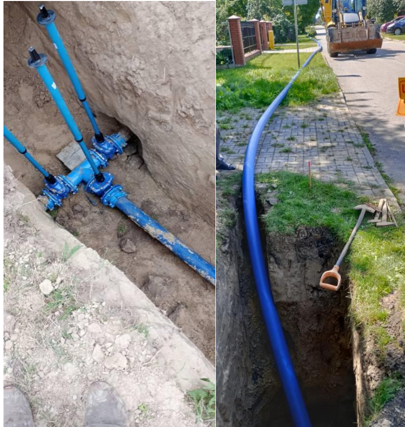
Fot. PGK i M. Budowa/rozbudowa sieci wodociągowej w ulicach Komandora Krawczyka i Króla Zygmunta Augusta w Hrubieszowie ”.
