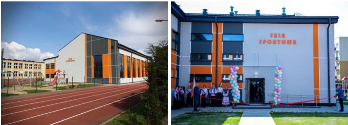
Rys. nr 1. Hala sportowa przy Szkole Podstawowej nr 1 w Hrubieszowie.
