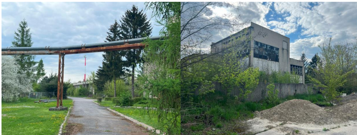
Zdjęcie 17. Budynki socjalne przy ul. Gródeckiej.
