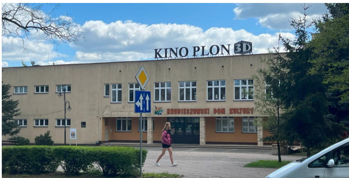
Zdjęcie 9. Budynek Hrubieszowskiego Domu Kultury – niezadawalający stan techniczny obiektu.
