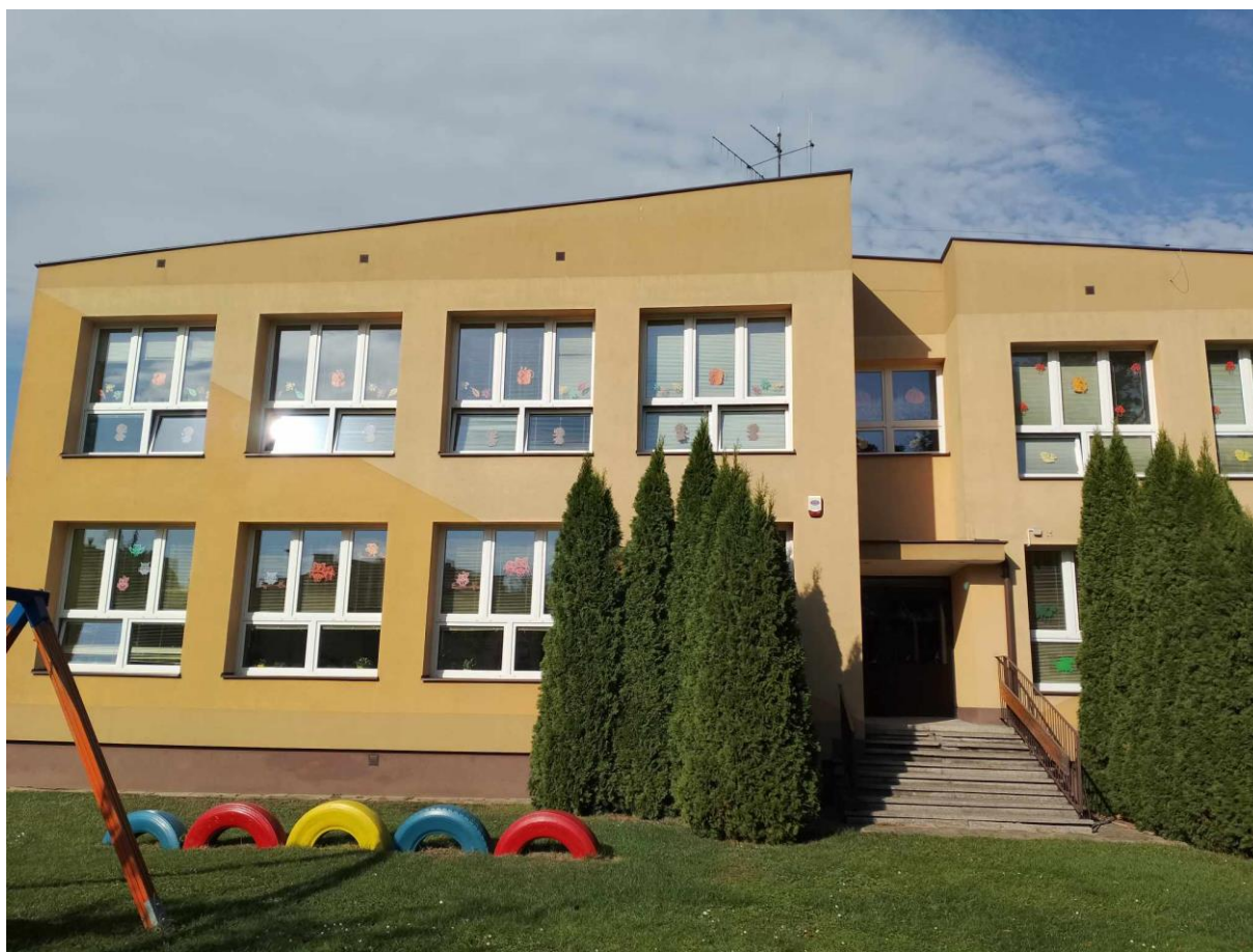
Rys. nr 5. Zdjęcie budynku Miejskiego Przedszkola Nr 2 od strony placu zabaw.
