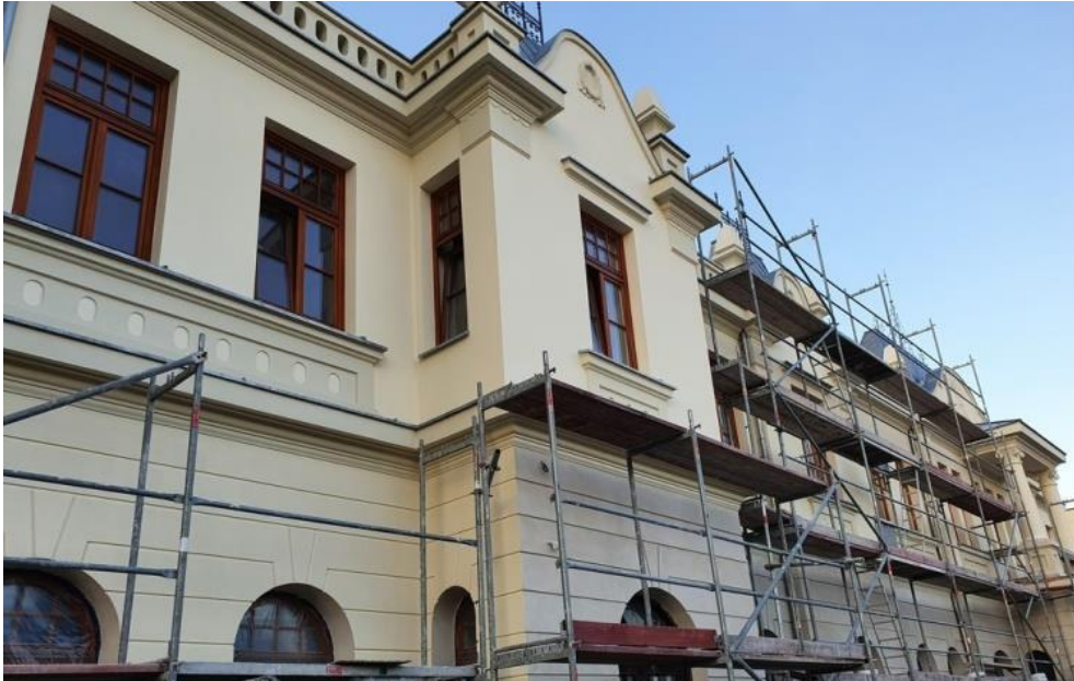
Fot. Budynek przy ul. 3 Maja 10 – aktualny stan zaawansowania prac (źródło: LubieHrubie.pl)
