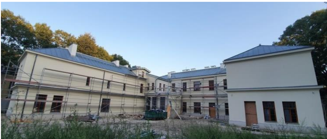
Fot. Budynek przy ul. 3 Maja 10 – aktualny stan zaawansowania prac (źródło: LubieHrubie.pl)
